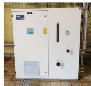
Les deux équipements renouvelés permettent une meilleure régulation plus adaptée aux débits de fonctionnement de l'usine 150 et 300 m<sup>3</sup>/h et une meilleure répartition de l'ozone injecté.
