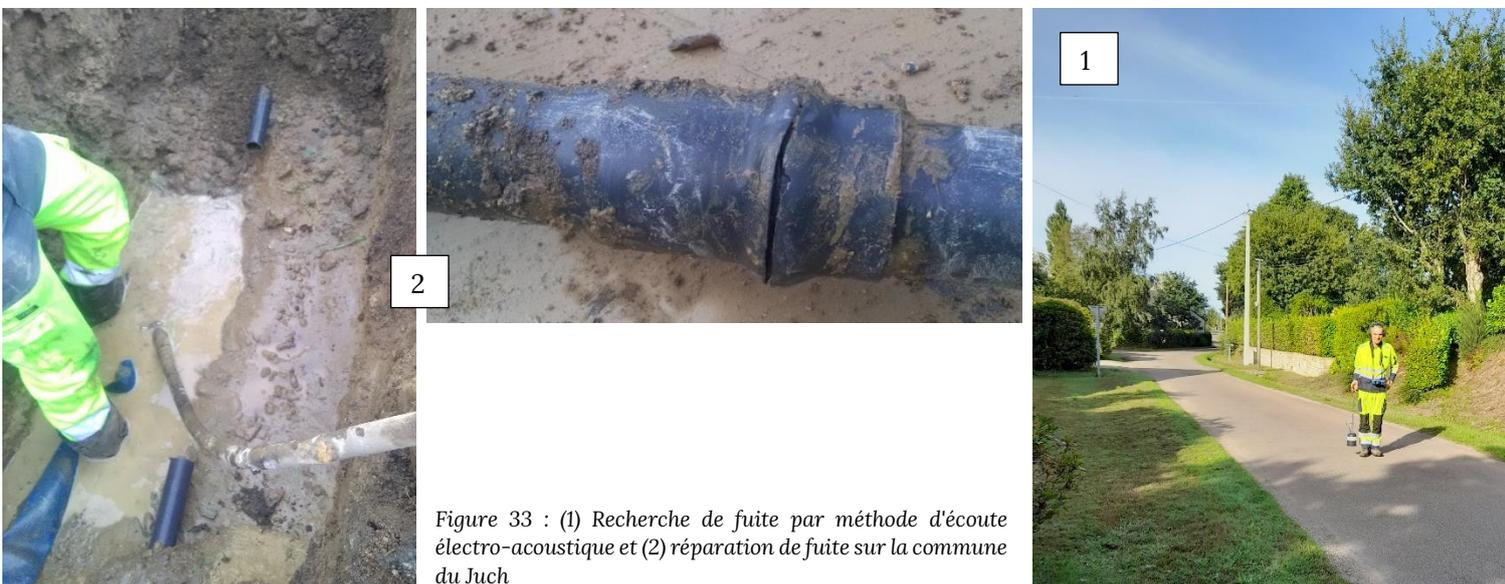
Figure 33 : (1) Recherche de fuite par méthode d'écoute électro-acoustique et (2) réparation de fuite sur la commune du Juch
