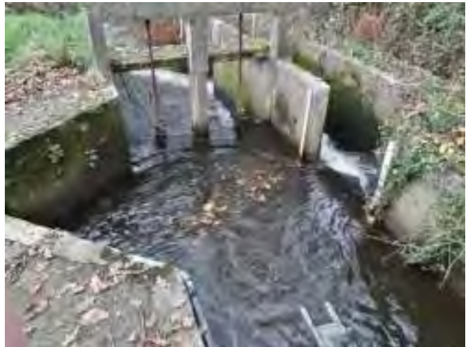
Figure 11 : Couple de vannes en travers du cours d'eau
