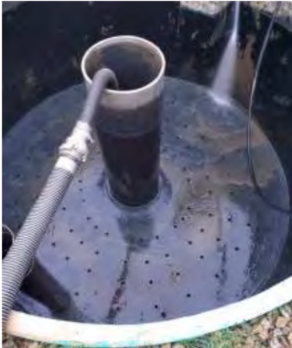
Figure 59 Renouvellement de la pouzzolane
