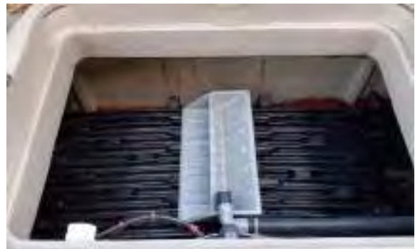
Figure 63 : Filtre "Coco" est une filière compacte qui permet de traiter les eaux (déjà prétraitées par la fosse toute eaux) et peut remplacer une filière traditionnelle
