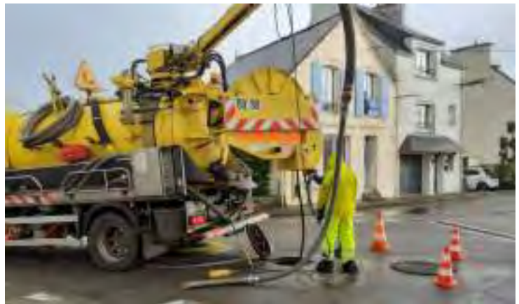
Figure 42 : Hydrocurage aux Sables Blancs
