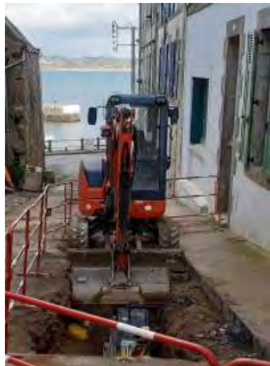
Figure 34 : Obturation partielle de la conduite AEP rue Couëdic par des dépôts métalliques et travaux de renouvellement
